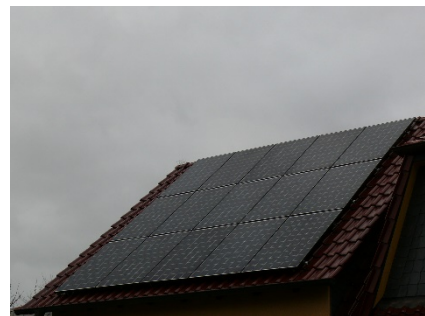
Ansicht des geneigten Daches mit der PV-Anlage nach der Schadenbeseitigung
