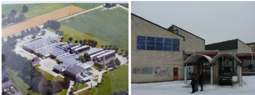
Abb.: 1 Links: Luftbild des Objektes; rechts: Südansicht Haupteingang des Objektes
