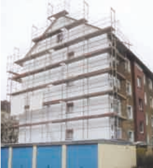
Abb. 19: Energetische Modernisierung eines Mehrfamilienhauses mit Wärmedämmverbundsystem
