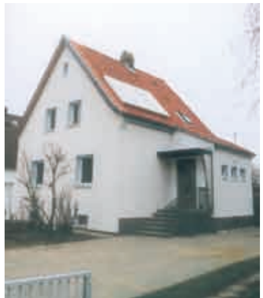
Abb. 29: Solarkollektoren im Bestand
