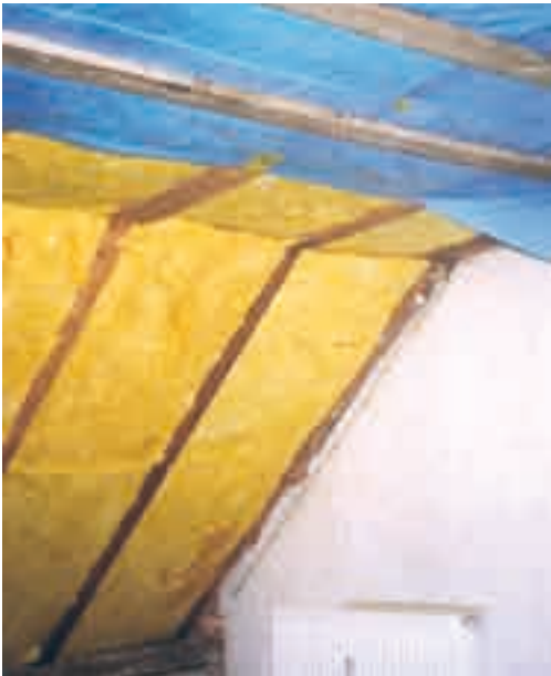
Abb. 23: Nachträgliche Dachdämmung bei einem Einfamilienhaus
