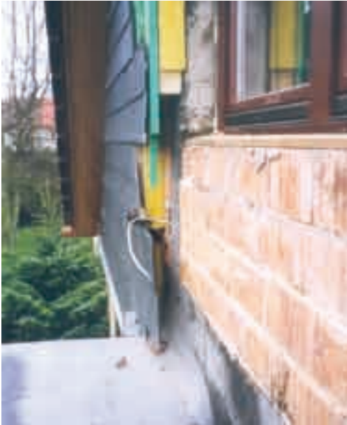
Abb. 21: Energetisch modernisiertes Wohngebäude mit Vorhangfassade
